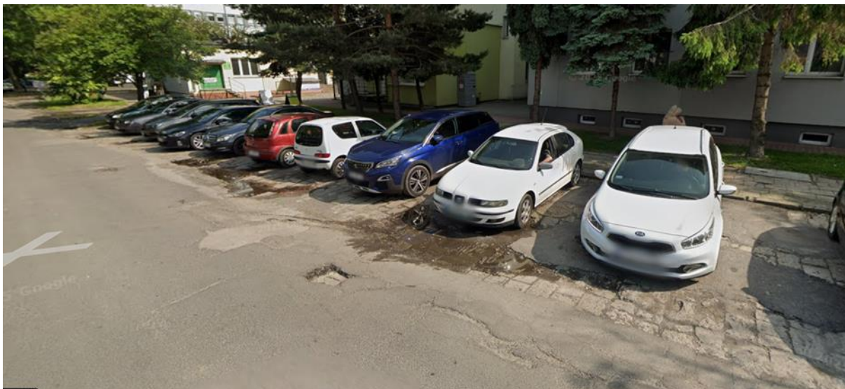
Fot. nr 2 – uszkodzona nawierzchnia
